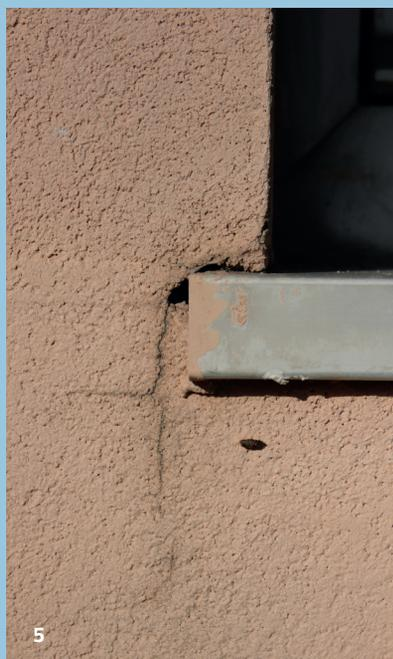
**Figura 5.** Fissuração do revestimento do sistema nos cantos dos vãos, que resulta do inadequado tratamento dos pontos singulares (p. ex., ausência de colocação de armadura de reforço nos cantos dos vãos).
