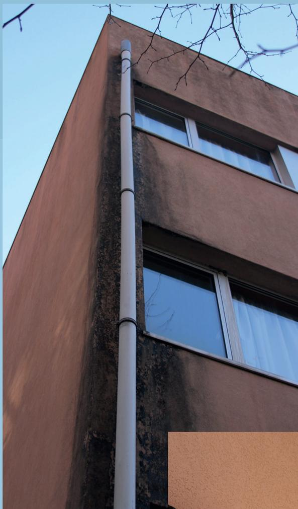
**Figura 3.** Execução incorreta ou ineficiência da drenagem em tubo de queda, o que faz com que haja contacto permanente de água com a fachada, potenciando fenómenos de colonização biológica.
