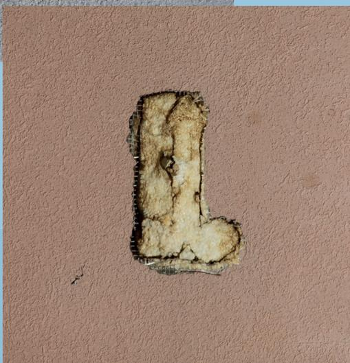
**Figura 7.1 | 7.2** Perfuração pontual do sistema, que pode dever-se a atos de vandalismo causados pelos utilizadores, mas também ter origem em casos de choque fortuito.
